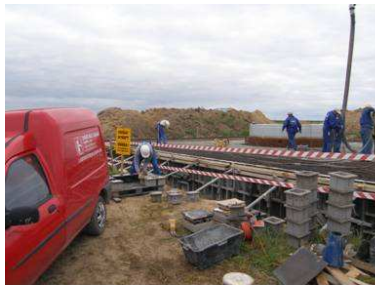
Zalanie fundamentów pod ósmą turbinę
